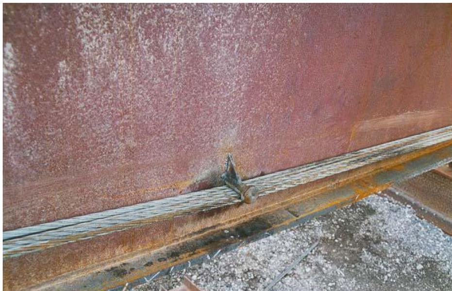
FIGURA 2-12 – DETALHE DE DESVIADOR COM 3 CABOS DE PROTENSÃO
