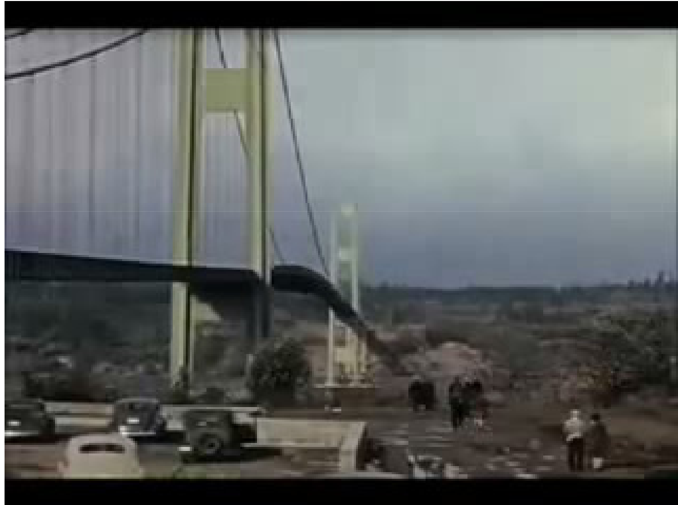
Arquivo: Filmes concreto / Pontes / Tacoma Narrows Bridge Collapse
