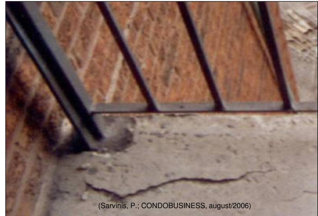
União do gradil às armaduras provocou corrosão galvânica nestas.
