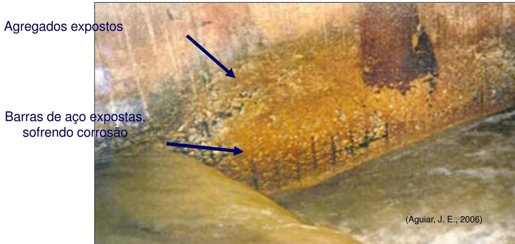
Erosão em galeria de água pluvial em região de degrau.
