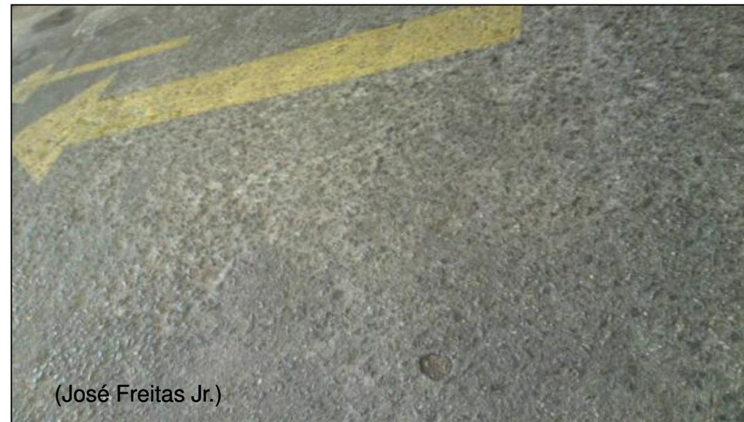
Desgaste superficial por abrasão em pavimento de concreto.
