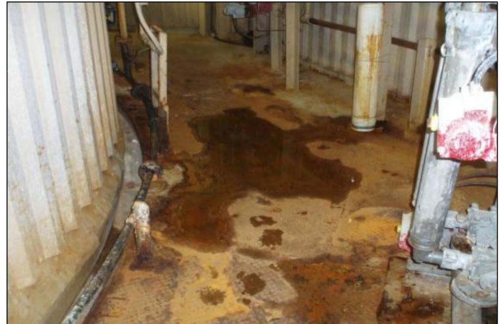
Aplicação excessiva e repetida ataca o concreto e corrói o aço.
