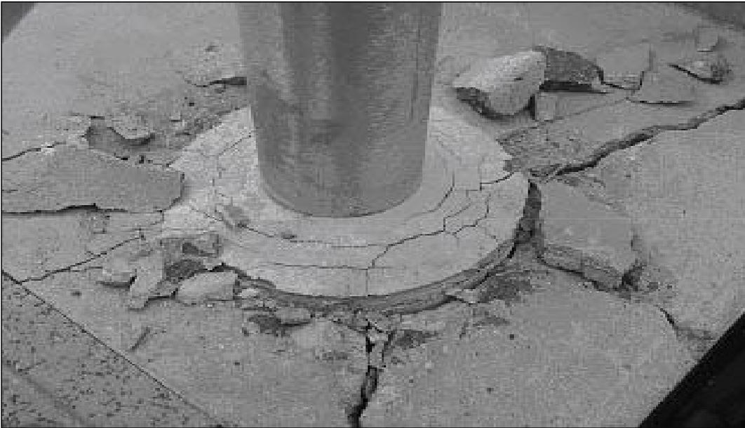
Expansão deletéria devido a existência de sulfato nos componentes do grante usado para fixação da peça metálica.
