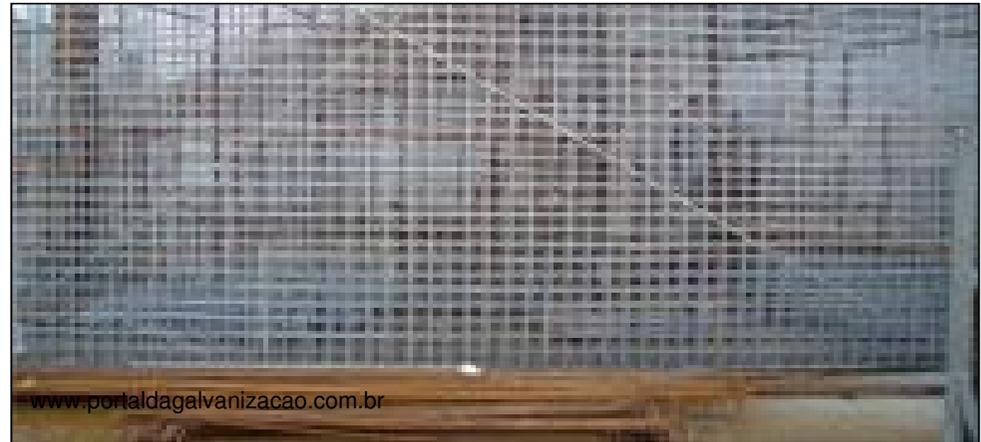
Devido a diferenças de potencial elétrico, o contato direto entre vergalhões galvanizados e não galvanizados promove a migração de íons de zinco para fora do concreto gerando manchas em sua superfície.
