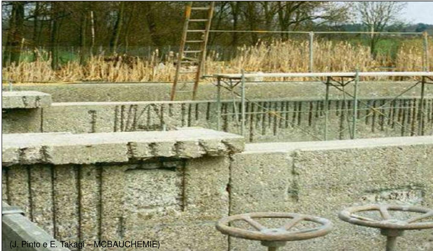
Ataque por ácido sulfúrico de origem biogênica
