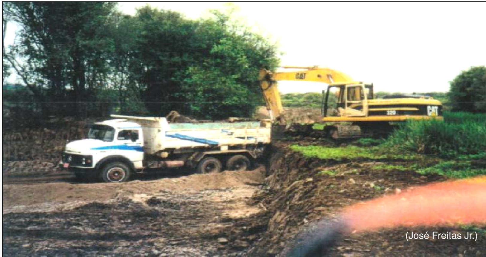
Remoção de camada de terra orgânica
