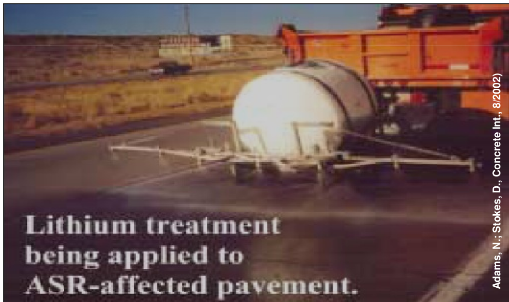
Aplicação de lítio por impregnação em pavimento afetado por RAA.
