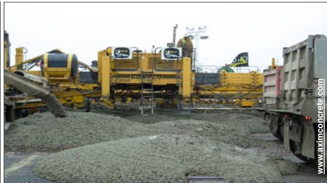
Aditivo a base de lítio misturado na massa de concreto para pavimento.
