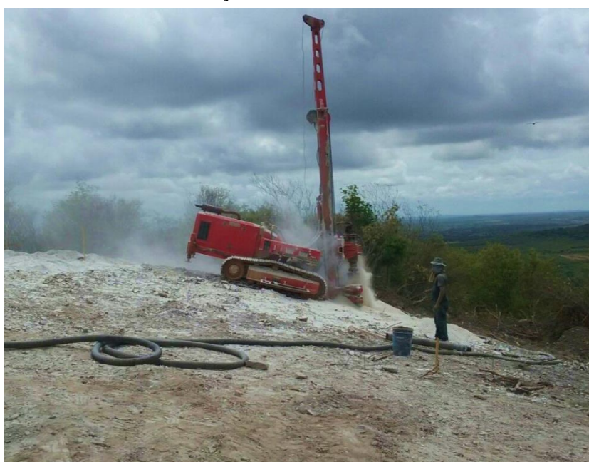
FIGURA 3 – PERFURAÇÃO EM ROCHA COM AR COMPRIMIDO
