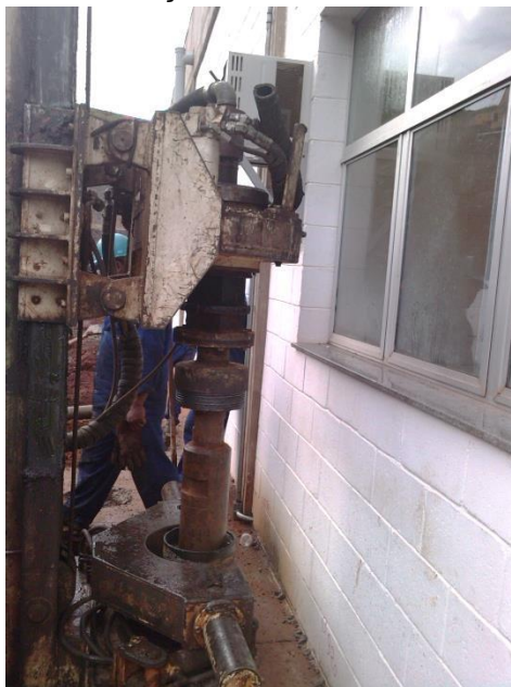
FIGURA 11 – EXECUÇÃO DE ESTACA PRÓXIMA À EDIFICAÇÃO
