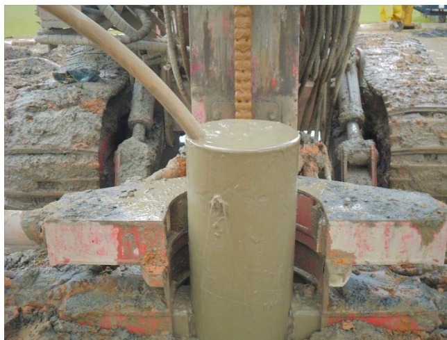
FIGURA 6 – INJEÇÃO DE ARGAMASSA
