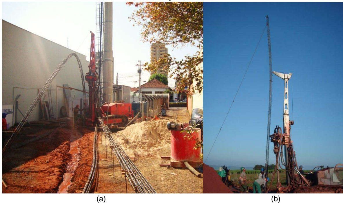
FIGURA 5 – LANÇAMENTO DA ARMADURA
