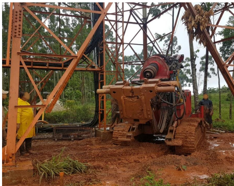
FIGURA 9 – REFORÇO DE FUNDAÇÃO DE TORRE DE TELECOMUNICAÇÕES
