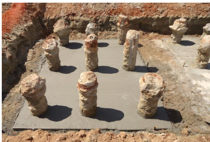
FIGURA 8 – TOPO DAS ESTACAS ANTES DO ARRASAMENTO
