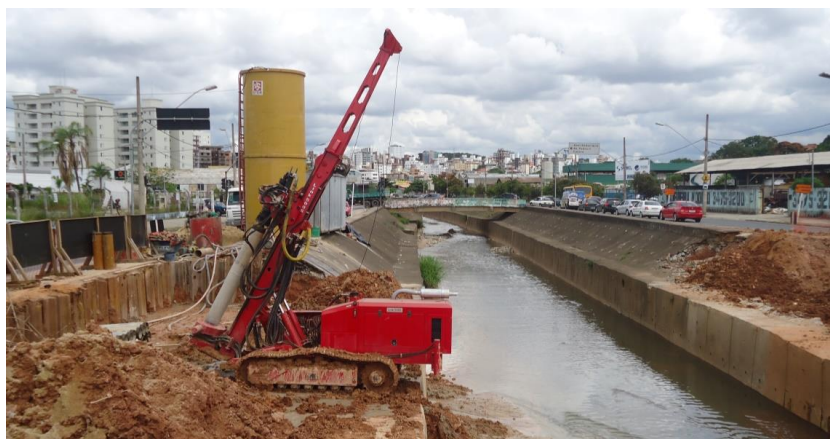
FIGURA 10 – OBRA DE ALARGAMENTO DE CANAL DE RIO, COM ÁREA DE TRABALHO REDUZIDA
