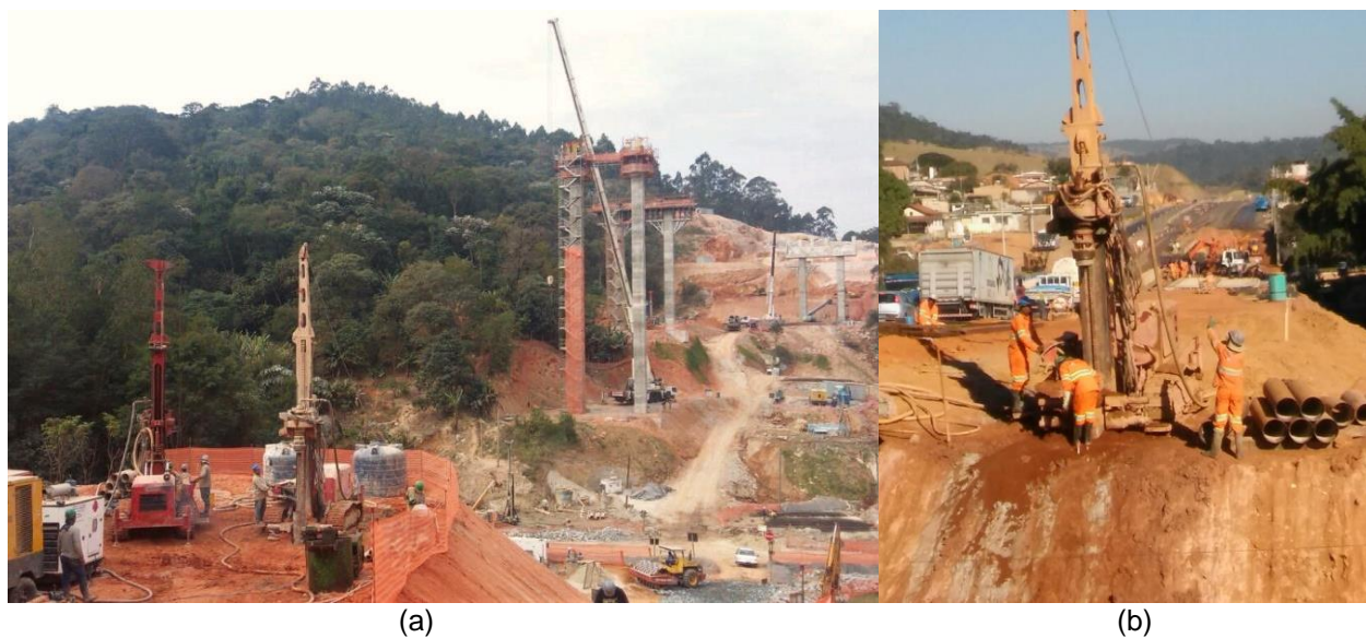
FIGURA 12 – OBRAS RODOVIÁRIAS, COM FUNDAÇÕES EM ESTACA RAIZ: (a) ponte; (b) alargamento de pista
