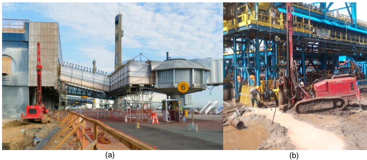
FIGURA 13 – APLICAÇÃO DE ESTACAS RAIZ EM OUTRAS OBRAS: (a) aeroportos; (b) porto
