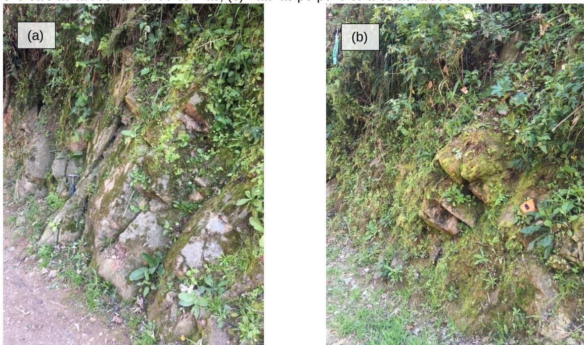
Figura 25 - Afloramento de xisto do Complexo Gnáisse-Migmatito: (a) fraturas paralelas e transversais ao talude formando cunhas; (b) fraturas perpendiculares ao talude.
