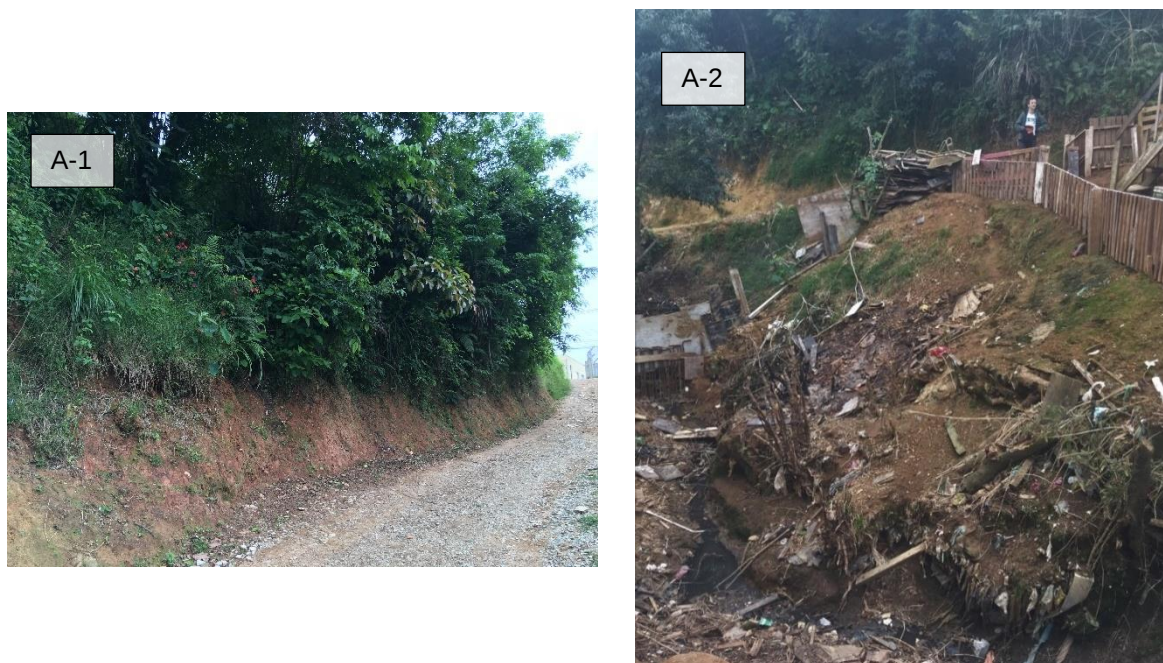
Figura 24 - Afloramentos de solo de aterro em Vila Nova
