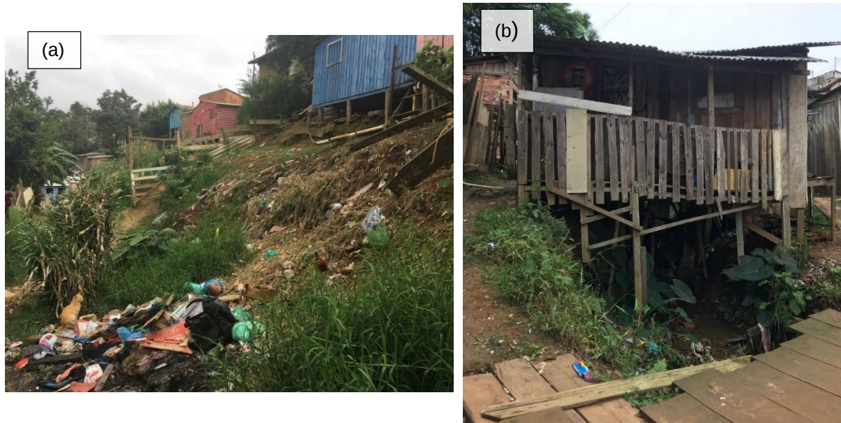
Figura 3 – (a) Deposição e acúmulo de resíduos sólidos urbanos no sopé de um aterro; (b) Padrão de edificação e ocupação: palafita sobre o leito do córrego
