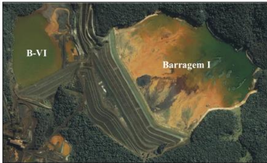
FIGURA 20 - VISTA AÉREA DA BARRAGEM I E BARRAGEM IV
