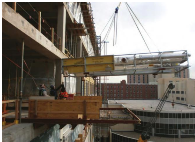
FIGURA 7 – UTILIZAÇÃO DE PEÇAS MONTADAS OFFSITE
