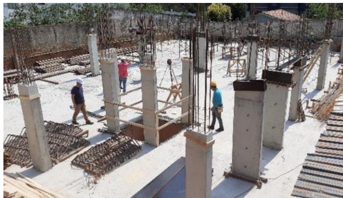
FIGURA 11 – MONTAGEM DE FORMAS DA OBRA A
