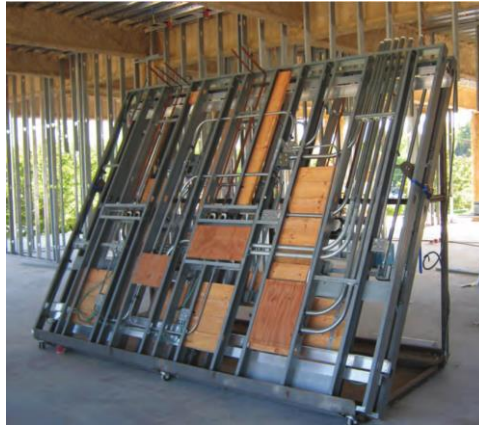
FIGURA 5 – PÁINEIS PRÉ-FABRICADOS PRONTOS PARA A INSTALAÇÃO
