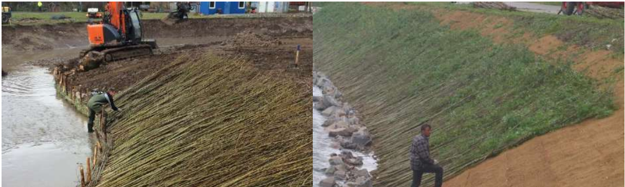
FIGURA 41 – ESTEIRAS VIVAS COM FEIXES VIVOS E COM ENROCAMENTO Esteira viva com feixes vivos Esteira viva com base em enrocamento
