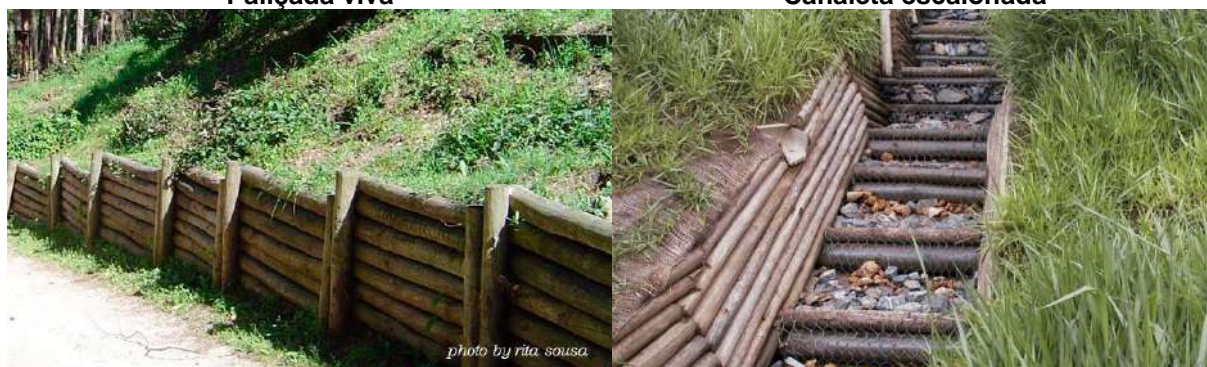
FIGURA 58 – COMPARAÇÃO ENTRE PALIÇADAS VIVAS E CANALETAS ESCALONADAS Paliçada viva Canaleta escalonada
