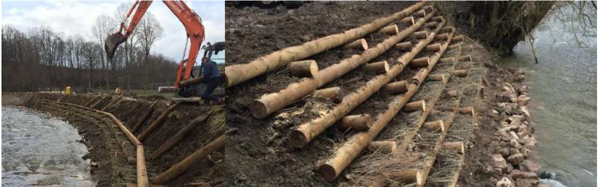
FIGURA 40 – PAREDES KRAINER EM CONSTRUÇÃO E APÓS FINALIZAÇÃO
