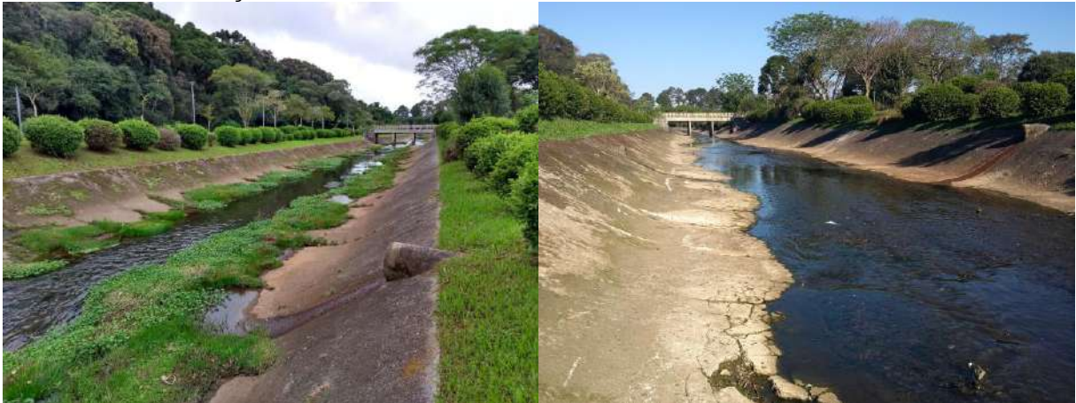
FIGURA 18 – VISTA DO TERCEIRO TRECHO DO RIO BACACHERI, A MONTANTE DA PONTE Março de 2019 Outubro de 2019
