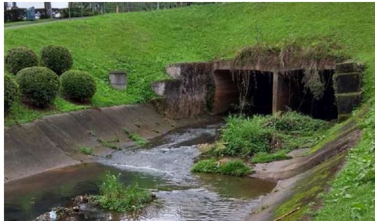
FIGURA 16 – BUEIRO DUPLO CELULAR DE CONCRETO NA ENTRADA DO RIO BACACHERI NO PARQUE GENERAL IBERÊ DE MATTOS
