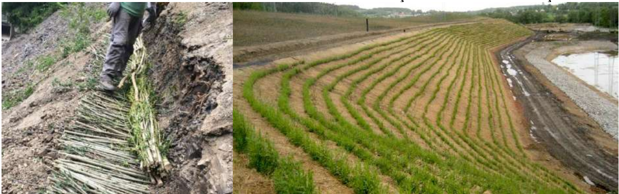
FIGURA 39 – BANQUETAS VEGETADAS EM CONSTRUÇÃO E APÓS FINALIZAÇÃO
