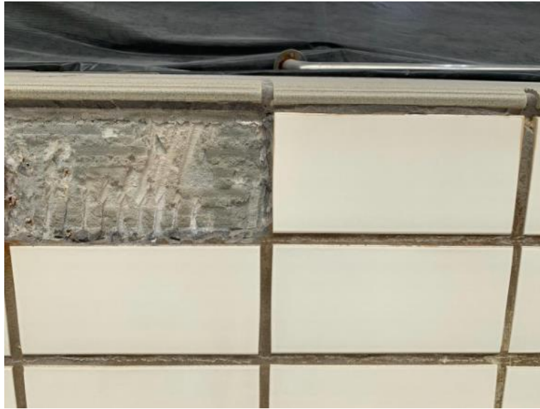
Figura 16 - Ausência do revestimento em um dos trechos da piscina (Os autores, 2019).
