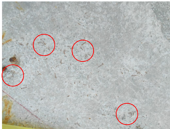
FIGURA 13 - LAJE ARMADA COM FIBRAS DE AÇO.
