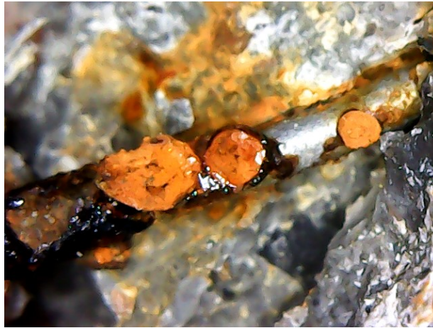
FIGURA 5 - CORROSÃO POR PITES EM FIBRA DE AÇO, EM FOTO AMPLIADA COM LUPA ELETRÔNICA.
