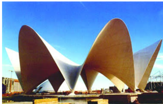
FIGURA 1- COBERTURA EM CONCRETO ARMADO E REFORÇADO COM FIBRAS DE AÇO.
