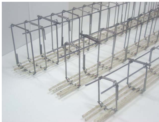
Figura 10 – Armaduras das vigas: longitudinal (GFRP) e transversal (CA 60)
